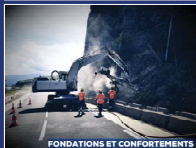
FONDATEMENTS ET CONFORTEMENTS
